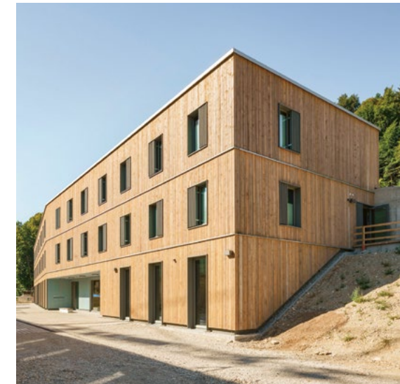
Nah am biologischen Kreislauf: der Strohballenbau des Klosters Plankstetten, Haus St. Wunibald
