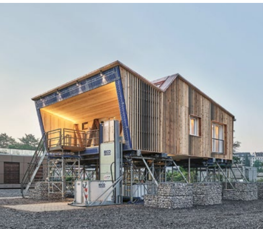
Der kreislauffähige Prototyp RoofKIT für Sanierungen und Aufstockungen im Städtebau
