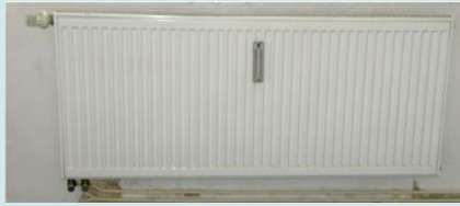
Plattenheizkörper
