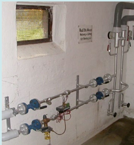
direkte Übergabe ohne Wärmeübertragung (nur Heizung)
