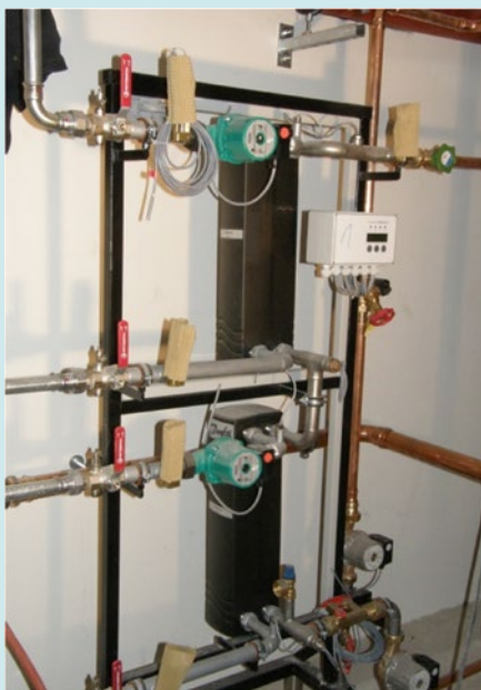
Durchlaufwassererwärmung mit Wärmeübertrager
