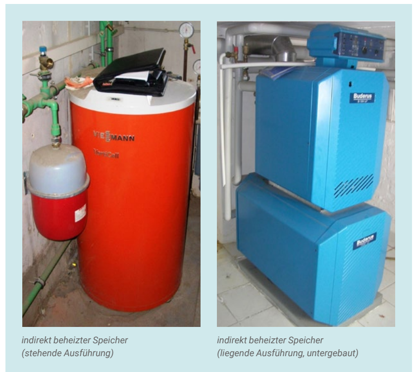
Abb. 39: Liegender und stehender Trinkwarmwasserspeicher
