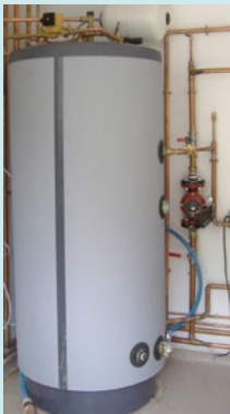
Kleinanlage (bivalenter Solarspeicher)
