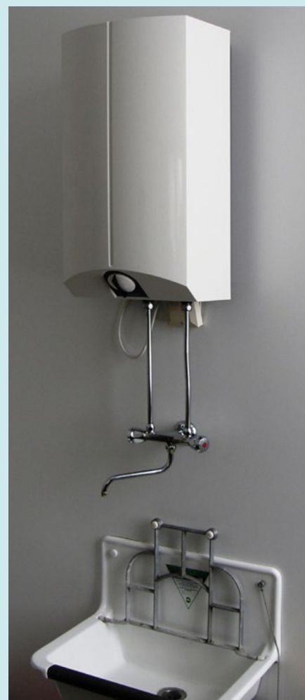
Elektrokleinspeicher (5 Liter)
