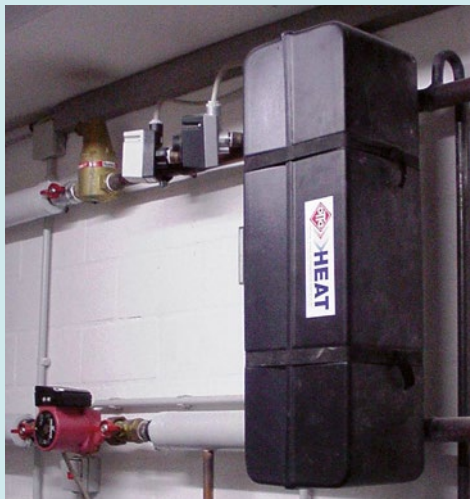
indirekte Übergabe mit Wärmeübertragung (nur Heizung)
