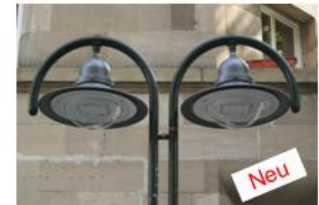
In Bereichen mit erhöhten gestalterischen Anforderungen wurden die ineffizienten HQL-Leuchten durch in Bauform angepasste hocheffiziente LED-Leuchten ersetzt.
