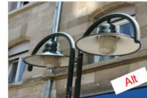
In Bereichen mit erhöhten gestalterischen Anforderungen wurden die ineffizienten HQL-Leuchten durch in Bauform angepasste hocheffiziente LED-Leuchten ersetzt.
