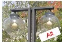
Modernisierung alter HQL- Kugelleuchten
