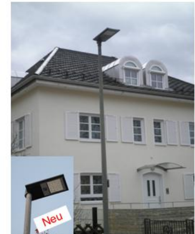
Austausch von HQL-Kofferleuchten durch neue LED-Leuchten in der Straßenbeleuchtung
