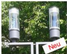
Im Bereich öffentlicher Plätze wurden alte Kugelleuchten durch neue zylinderförmige LED-Leuchten ersetzt.
