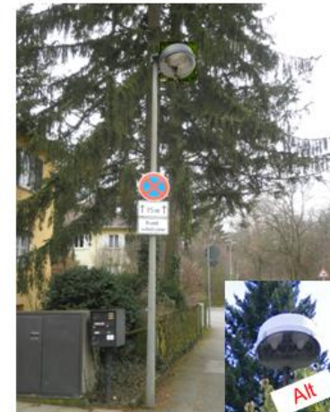
Austausch von HQL-Kofferleuchten durch neue LED-Leuchten in der Straßenbeleuchtung
