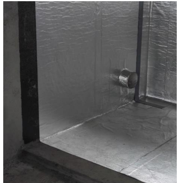
Abbildung 30. Beispiel dampfdichte Bitumenabdichtungen, Fa. Vedag , Foto dena, Schirmer
