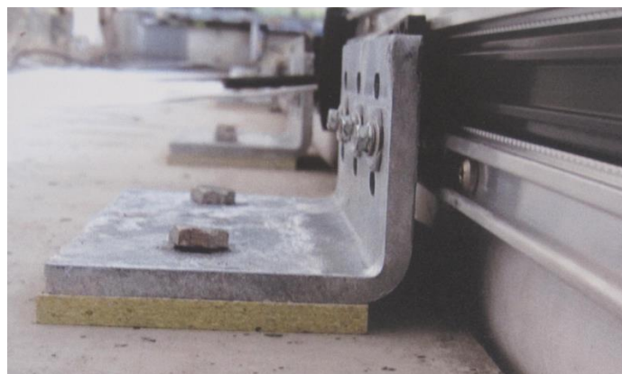
Abbildung 32. Vergleich \lambda -Werte Holz 0,14 W/(m K) und Phonotherm 0,073 W/(m K) (Foto dena, Schirmer)
