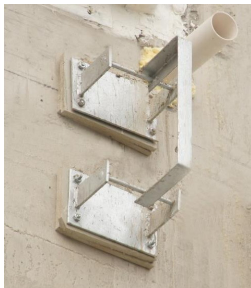
Abbildung 33. Thermische Trennung durch Phonotherm \lambda=0,073 W/(m K) (Foto dena, Schirmer)
