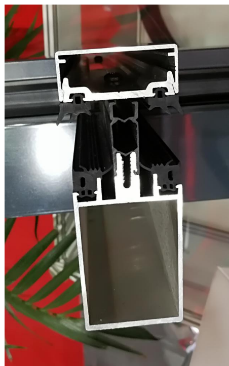
Abbildung 21. Beispiele von hocheffizienten thermisch getrennten Stahl-Türprofilen, Fa. Wuddy, Foto dena, Schirmer
