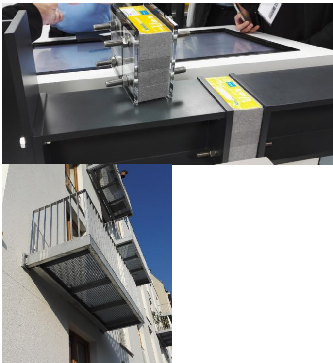
Abbildung 37. Thermisches Trennelement HIT von Halfen, Foto: dena, Schirmer
