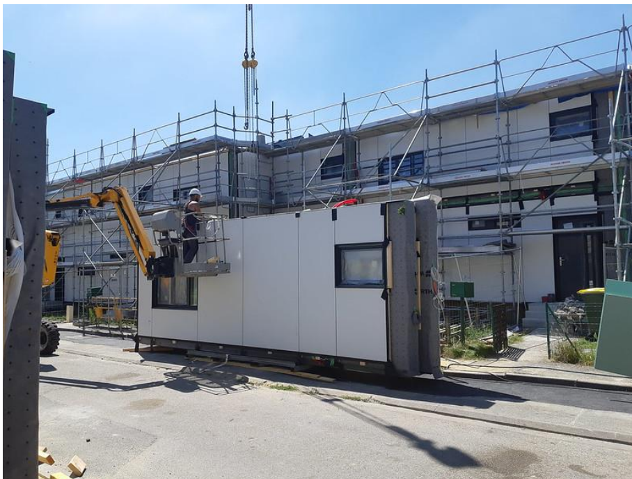
Abbildung 8: Baustelle in Longueau
