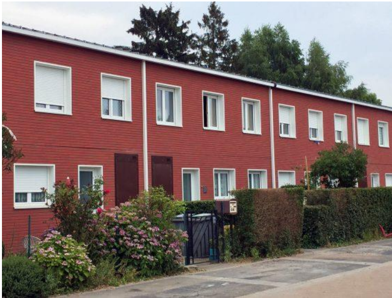
Abbildung 7: Hem Energiesprong Sanierungen
