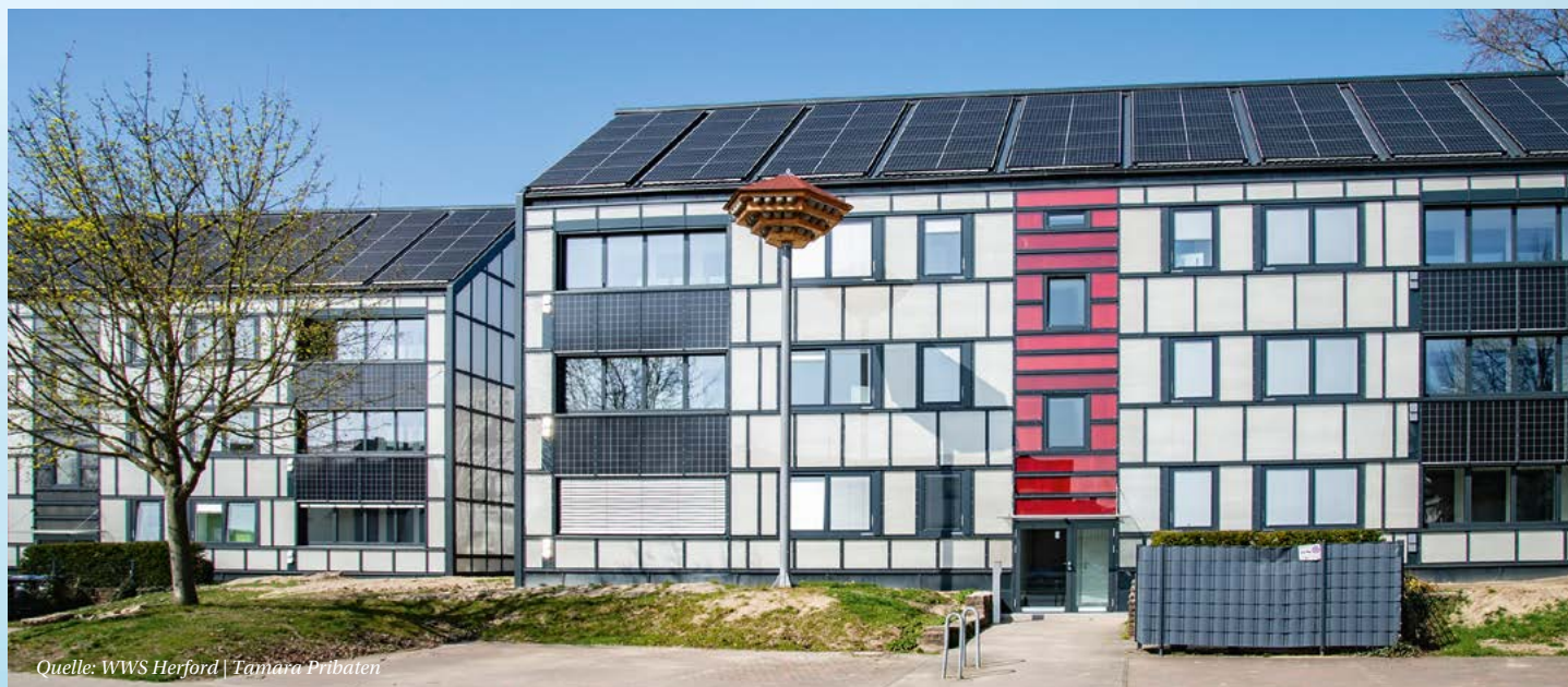
In Herford hat das VdW-Mitglied WWS Herford eine serielle Sanierungslösung mit innovativer Solarwabenfassade umgesetzt
