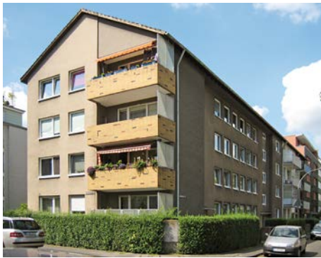
Nach vielen Hürden schloss die WGaV in Köln die Sanierung ihres Pilotprojekts ab. Das Controlling wird zeigen, ob die optisch ansprechende aber händisch montierte Alufassade Bestand hat
