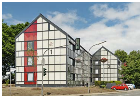
Piet Mondrian lässt grüßen: Die Fassade mit verglasten Solarwaben am sanierten Gebäude der WWS erfüllt wichtige energetische Funktionen
