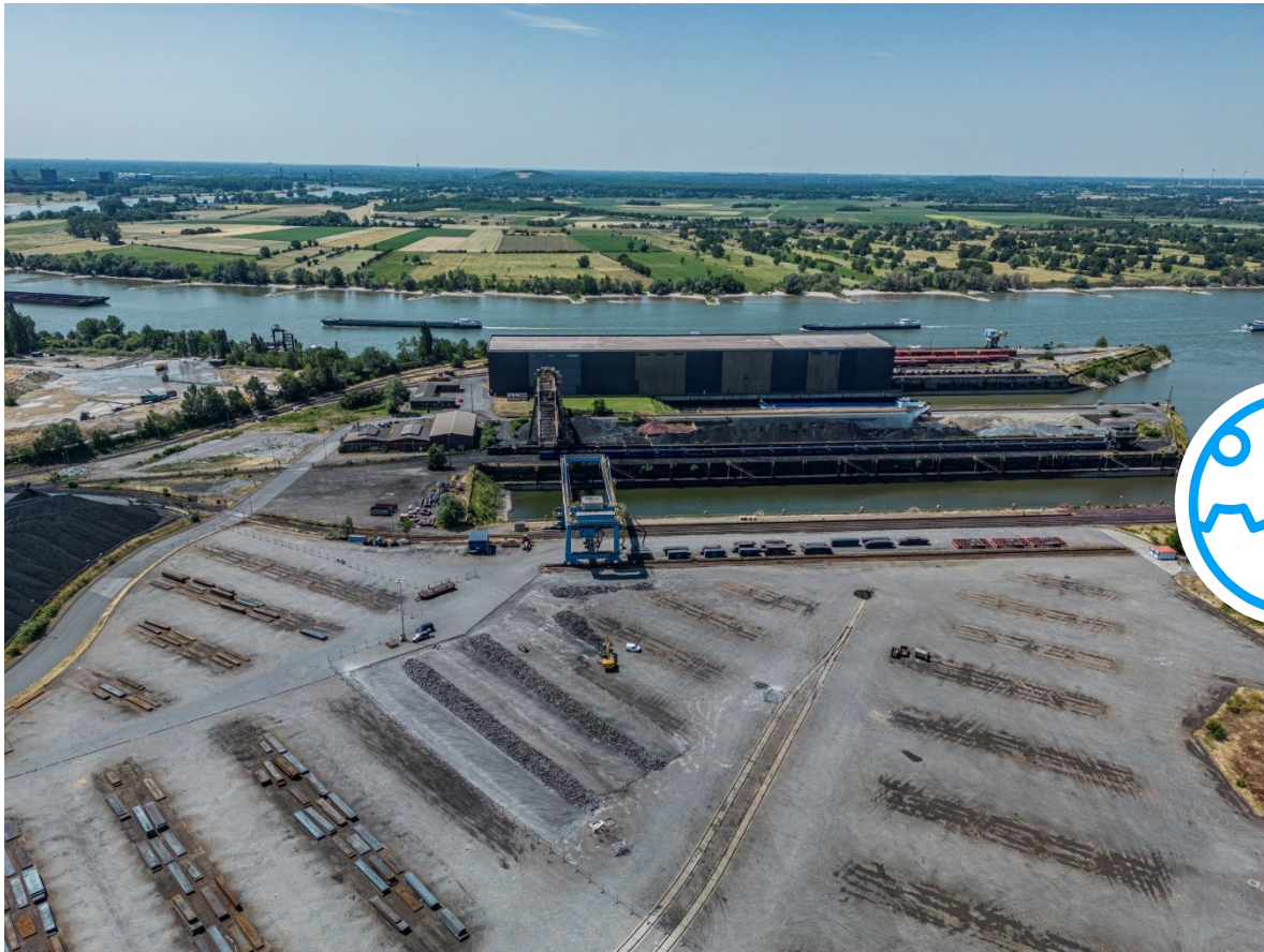
Rückbau des früheren Brammenlagers
