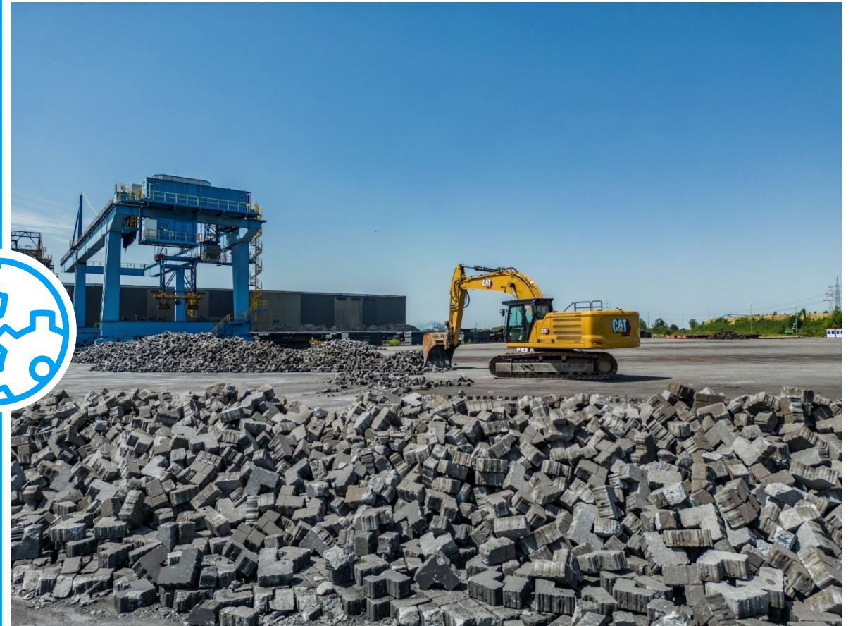
Baufeldvorbereitung ist gestartet
