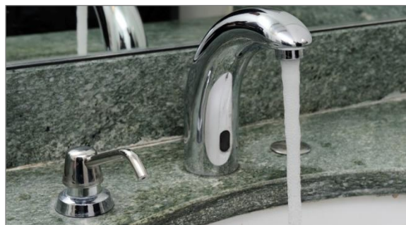
Berührungslos gesteuerte Wasserarmatur.
