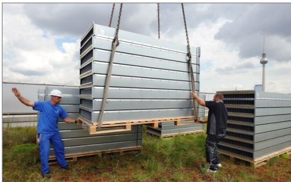
Lieferung der Bauteile für die solare Luftvorwärmung auf dem Neubaudach.
