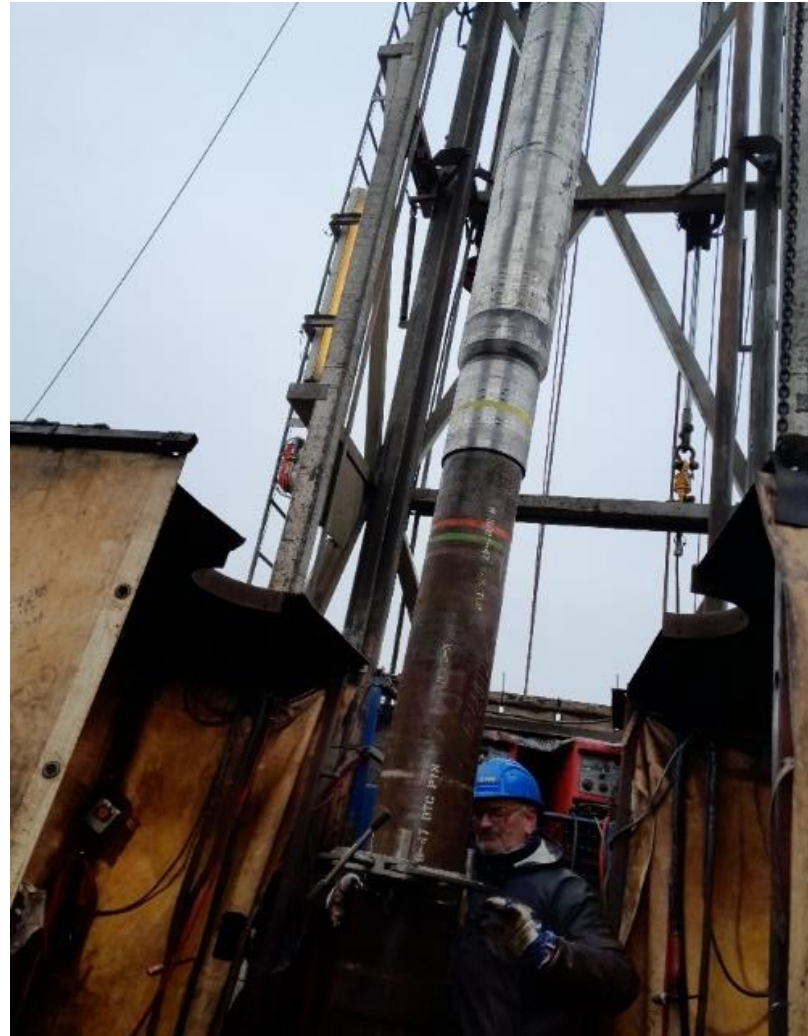
Verschweißen USAV-Sektion
