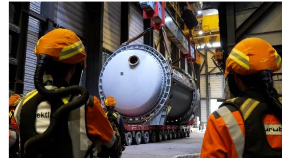
Juli 2024: Einbau Wasserstoff- Anodenöfen Aurubis
