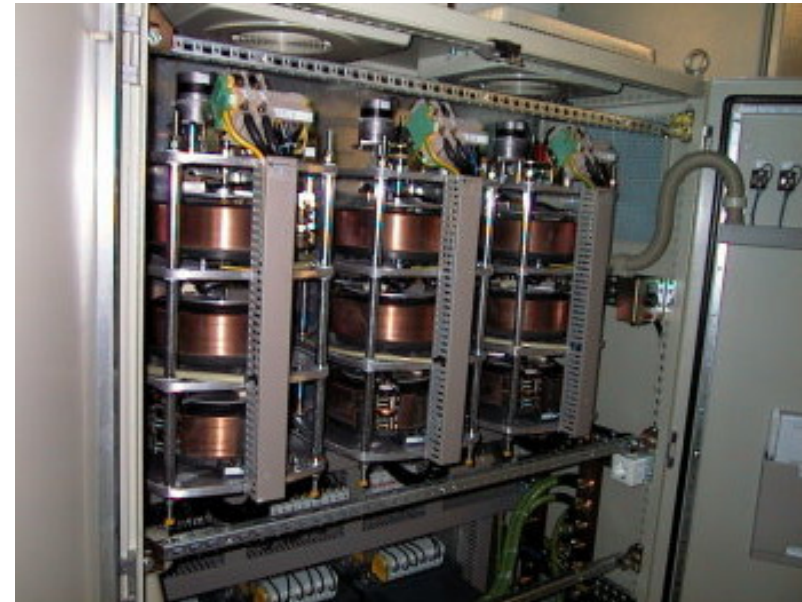
Ringkernstelltransformatoren (Größere Lichtstromkreise)
