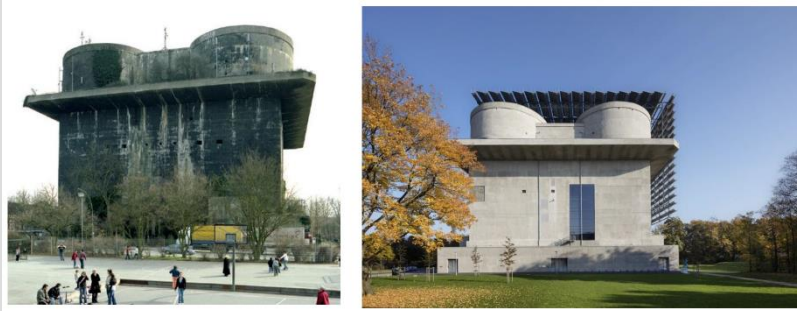
Abbildung 50: Flakbunker vor Sanierung (links) und nach der Sanierung (rechts) (IBA, 2014) (Grafik: IBA Hamburg GmbH/ Martin Kunze).
