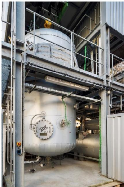
Abbildung 36: (links) 5 m hoher Feststoff-Wärmespeicher der Testanlage HOTREG am DLR, Stuttgart (Bild: DLR (CC BY-NC-ND 3.0)), (rechts) Geplanter Hochtemperatur-Wärmespeicher für die Demonstrationsanlage (Skizze: Paus Wurth R&E) (Stahl et al., 2012).
