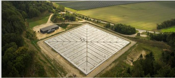
Abbildung 46: Erdbecken-Wärmespeicher in Dronninglund mit Solarkollektoren im Hintergrund (Mauthner et al., 2018) (Grafik: NIRAS).
